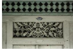
Gambar 2.Ukiran tebuk tembus atas pintu untuk pengudaraan yang baik
