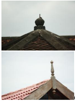
Gambar 4. Tunjuk langit berbentuk labu biasanya terletak di puncak bumbung pyramid dan yang menedak terletak di pemeleh.
