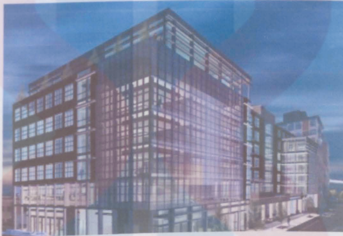
Rajah 5.3.1 (c) gambar menunjukkan struktur yang dibina daripada rangka besi adalah sangat kukuh
