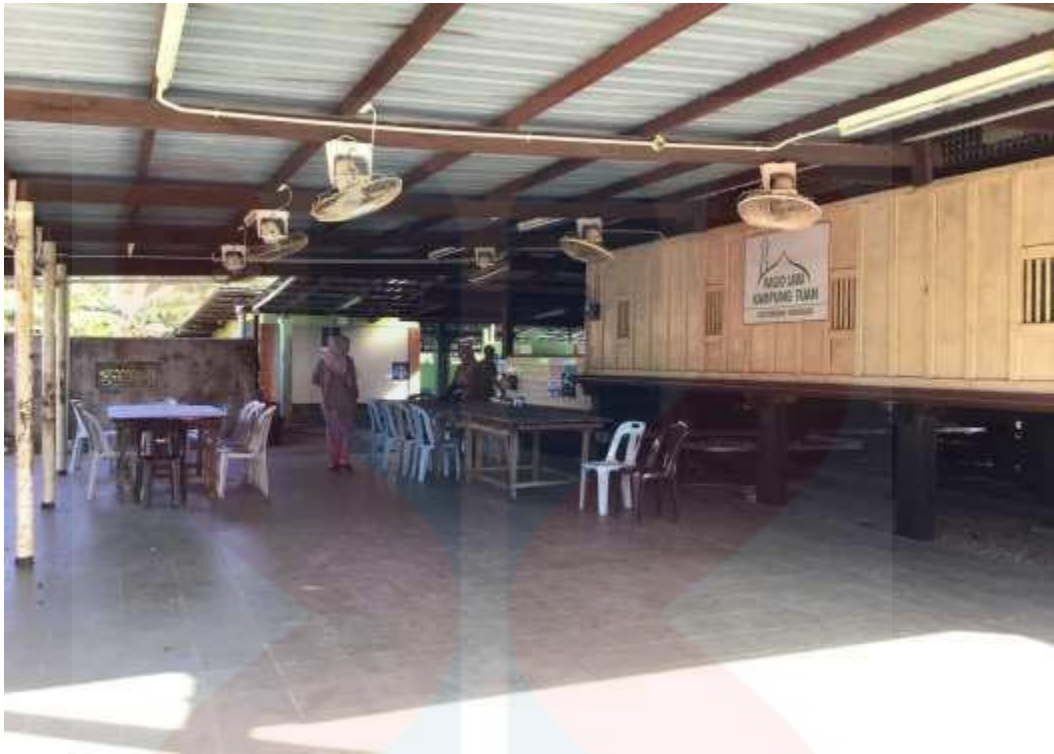
Gambar 3: Ruangan 'extension' yang disambung pada ruangan kanan Masjid Lama Kampung Tuan.
