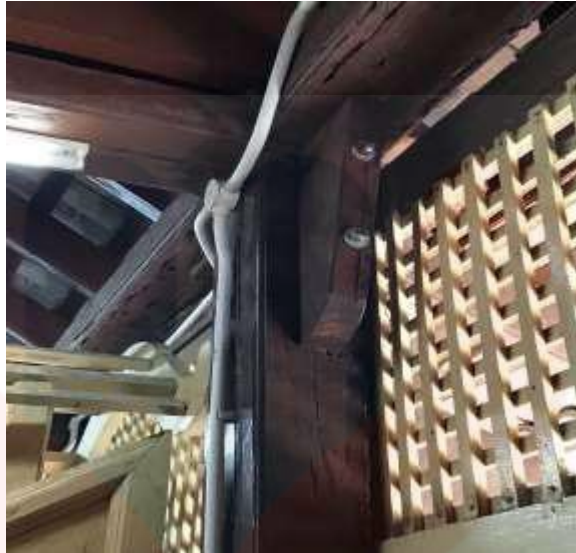
Gambar 4.3 Rangka tiang yang sebelum ini menggunakan pasak digantikan dengan penggunaan bolt dan nat.
