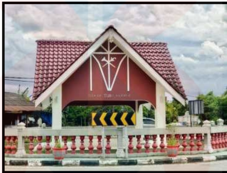
Rajah 4.22: Rajah menunjukkan Binaan Wakaf Tuan Farrer selepas proses penyelenggaraan.
