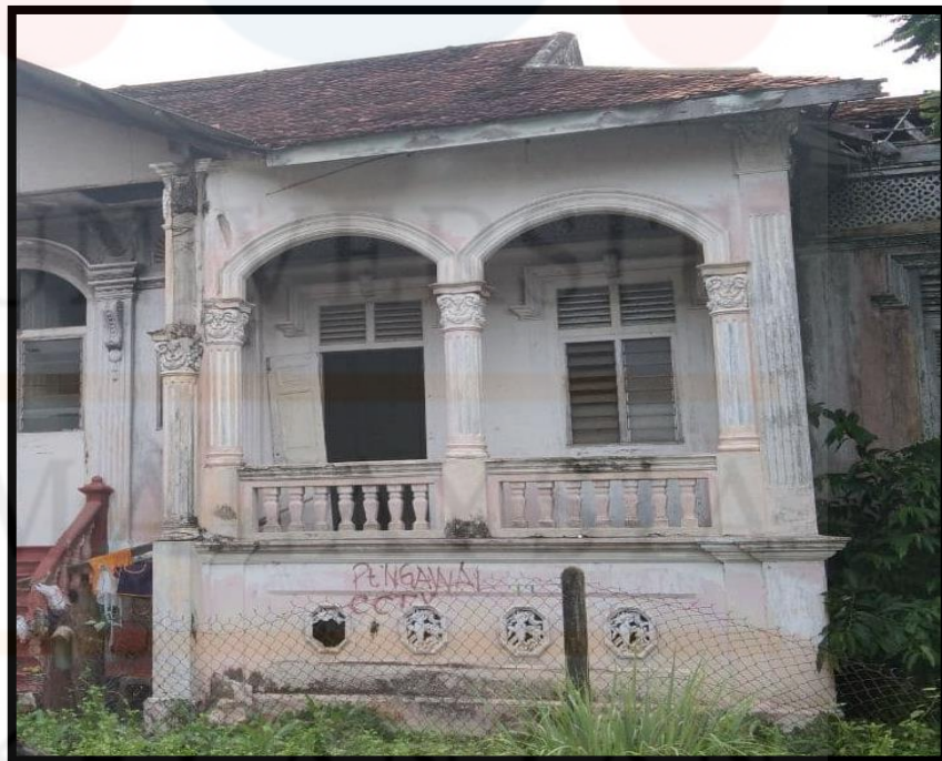
Rajah 4.9: Bahagian Beranda Dari Sudut Hadapan Rumah.
