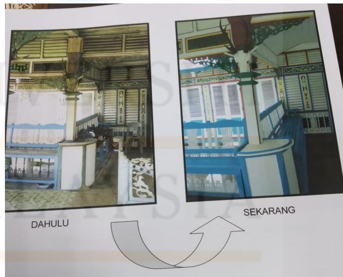
Rajah 4.24 : Tiang di beranda sebelum dan selepas pemuliharaan
