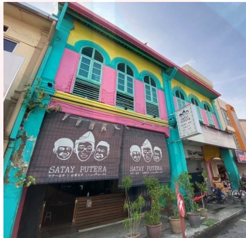
Rajah 4.1: Bentuk Bangunan Rumah Kedai Lama Yang Disuai Guna Semula
