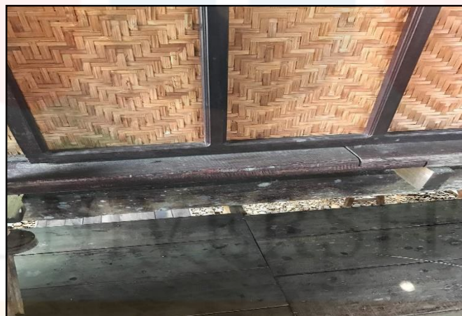
Rajah 4:8: Anyaman Buluh pada dinding (Sumber: Foto Kajian Lapangan)
