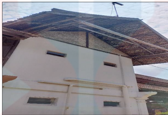
Rajah 6:6: Penambahan batu bata pada dinding
