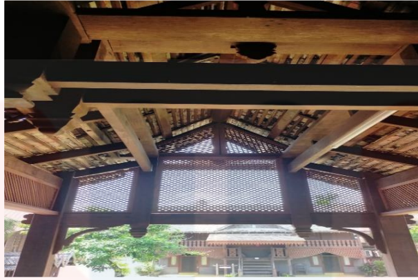
Rajah 6:0: Pemasangan jejaring baru
