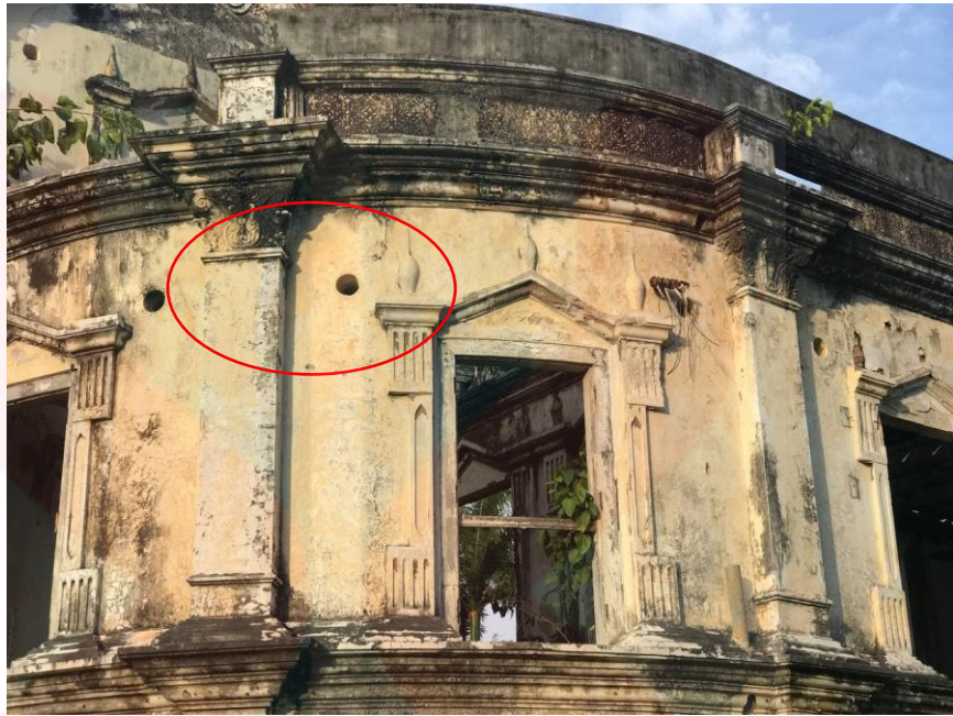
Gambar 4.14 menunjukkan liang pengudaraan yang berada di kedua-dua sisi bangunan Istana Sepachendera.
