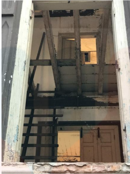
Gambar 4.21 menunjukkan struktur lantai bagi tingkat satu dan dua Istana Sepachendera.
