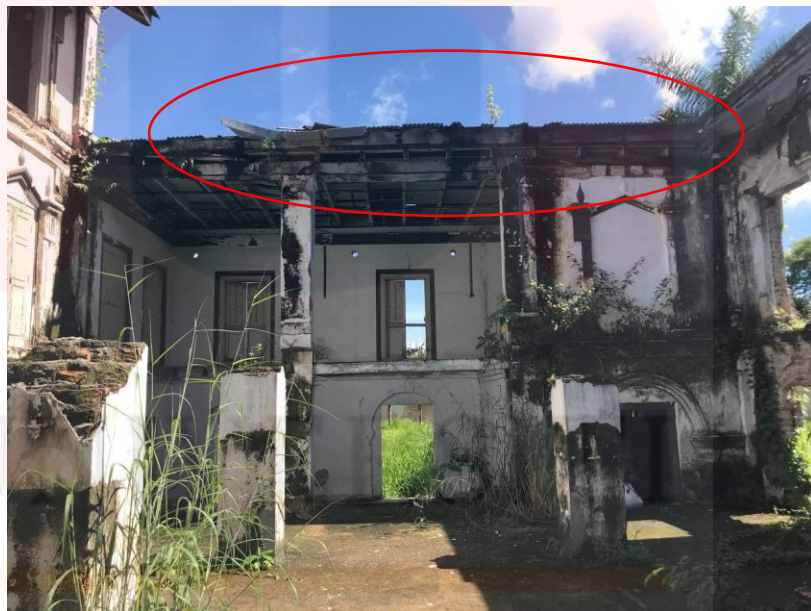
Gambar 4.12 menunjukkan atap asbestos pada bahagian bumbung Istana Sepachendera.
