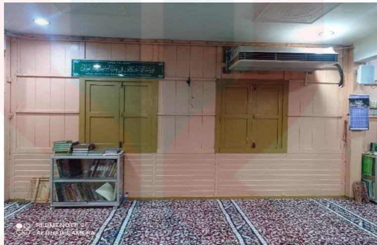
Rajah 4.3.4: Gambar menunjukkan dinding kanan yang ditukar kayu baharu
