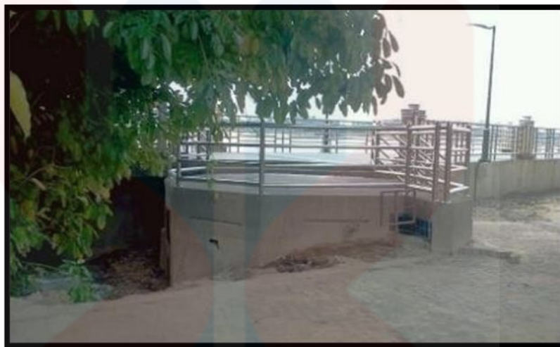
Picture 4.4: Kubu Jalan Tok Hakim Kota Bharu, Kelantan (Hashim, 2021).
