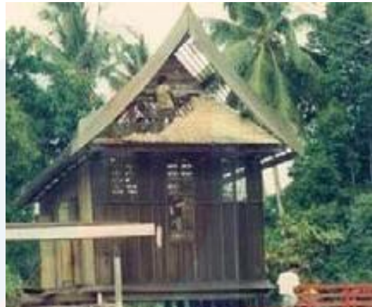
Rajah 4.4 Bumbung berpeleh yang sedang dibina oleh tukang rumah di rumah Pura Tanjung Sabtu.
