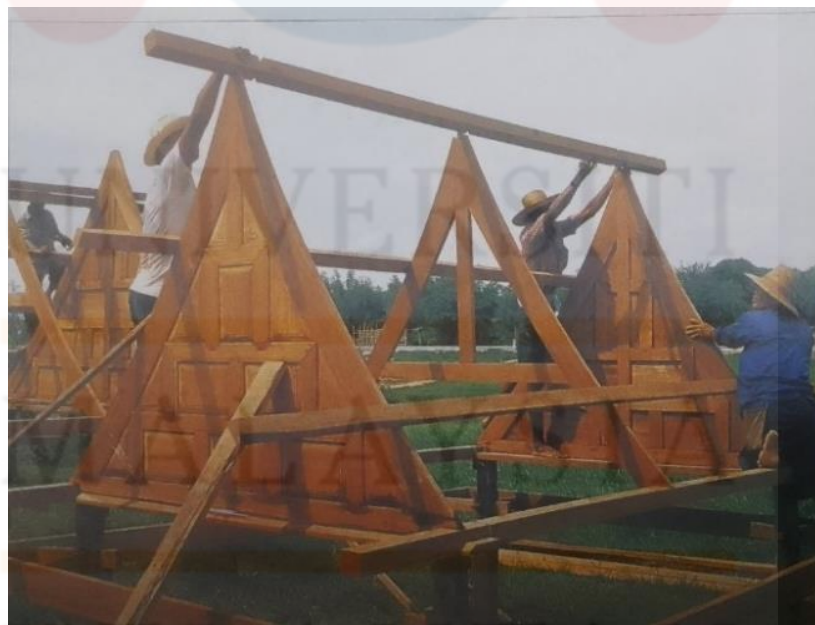
Rajah 4.6 Struktur kayu bumbung dipasang sebelum dinaikkan di atas kabin dan dipasang dengan jubin.
