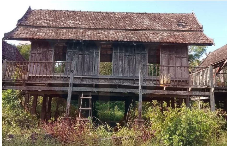
Rajah 4.9 Tangga asal pada struktur rumah Pura Tanjung Sabtu hilang dan digantikan dengan tangga sementara.
