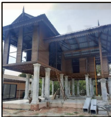
Rajah 5.3: Pembinaan Rumah Limas di Parit Bakar, Muar (Sumber: Gambar diambil oleh pengkaji pada 24 Ogos 2022)
