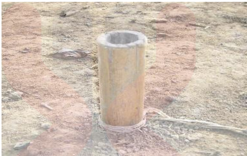
Gambar 6. Batang buloh yang ditanam kedalam tanah.
