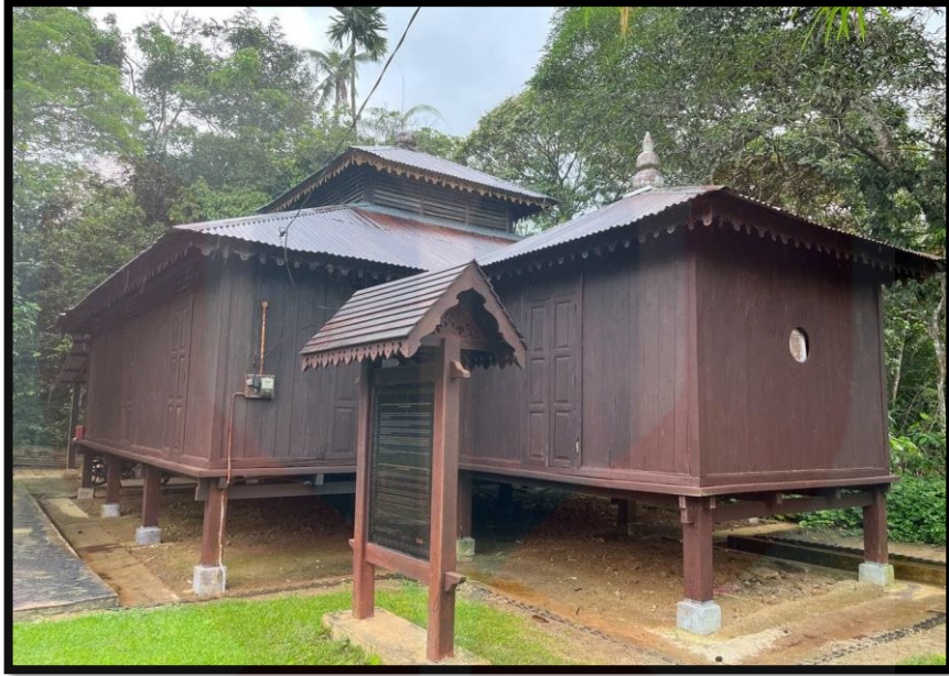
Rajah 4.13 : Ruang Pengudaraan Mihrab Masjid Lama Kampung Bolok Hilir, Temerloh
