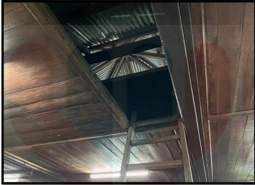
Rajah 4.11 : Ruangan Dalam Bumbung Masjid Lama Kampung Bolok Hilir, Temerloh
