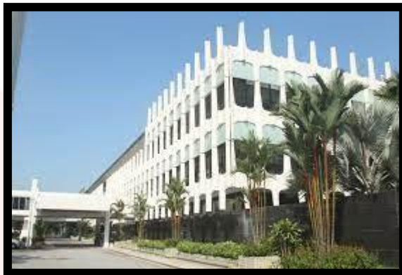
Rajah 2.2 : Bahagian bangunan parlimen yang memperlihatkan elemen bumbung rumah tradisional Melaka
