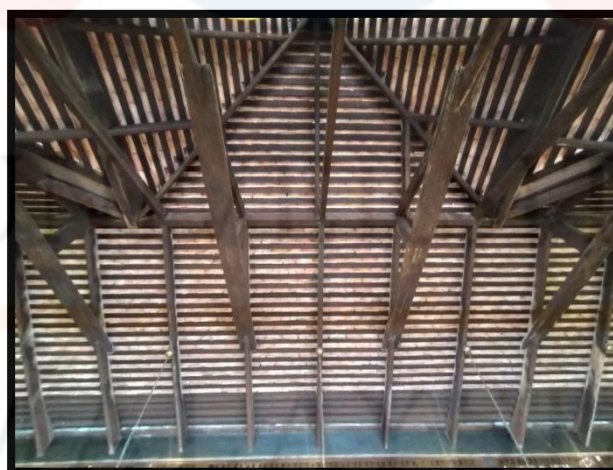
Rajah 40. Struktur Bumbung Dalam Yang Menggunakan Kayu Cengal
