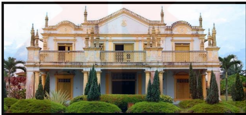
Rajah 6. Seni Bina Kolonial Istana Bandar Jugra
