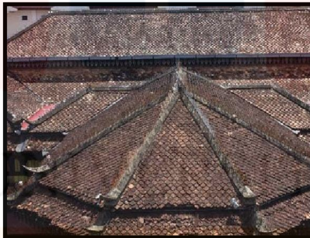
Rajah 30. Atap Singgora Yang Terdapat Pada Struktur Bumbung Istana Jahar
