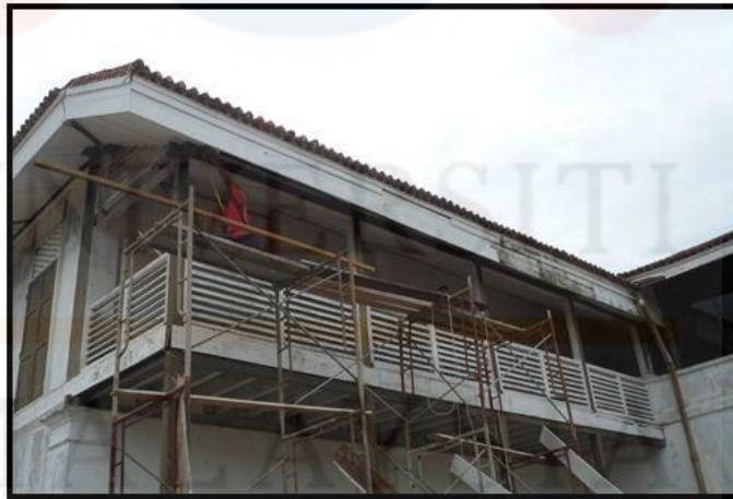
Rajah 4.6: Kerja-kerja pemuliharaan pada bahagian bumbung bangunan
