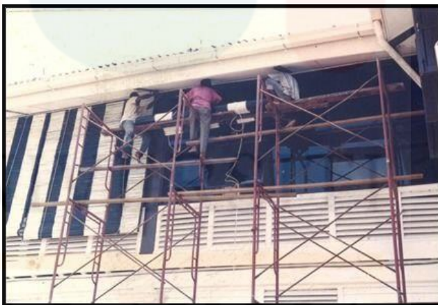
Rajah 4.7: Proses pemuliharaan pada bahagian hadapan bangunan Kompleks Sejarah Matang
