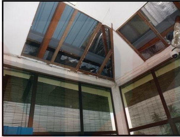
Rajah 4.4: Keadaan pada bahagian bumbung yang mengalami kerosakan disebabkan oleh beberapa faktor seperti kelembapan
