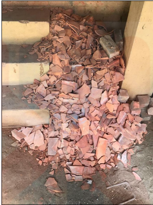
Rajah 2.10 : Keadaan atap singgora yang rosak semasa proses pembakaran
