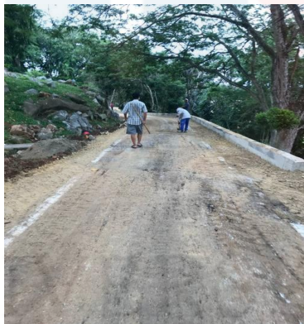
Rajah 4.2: Kerja penyelenggaraan yang dilakukan di Bukit Malawati
