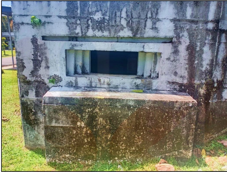
GAMBAR 4.49 : Kubu kebal ( pillbox ) tipologi 'Type 22' yang mempunyai elemen ' buttress '.
