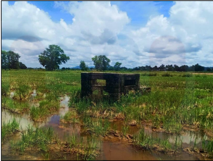
GAMBAR 4.17 : Pillbox di ampung Bohor, mukim Hutan Kampung.
