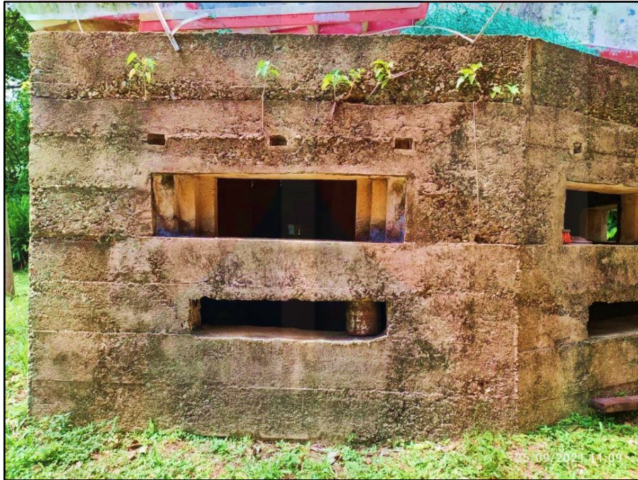
GAMBAR 4.32 : Dinding 'Type C' pada kubu kebal ( pillbox ) 'Type 22'
