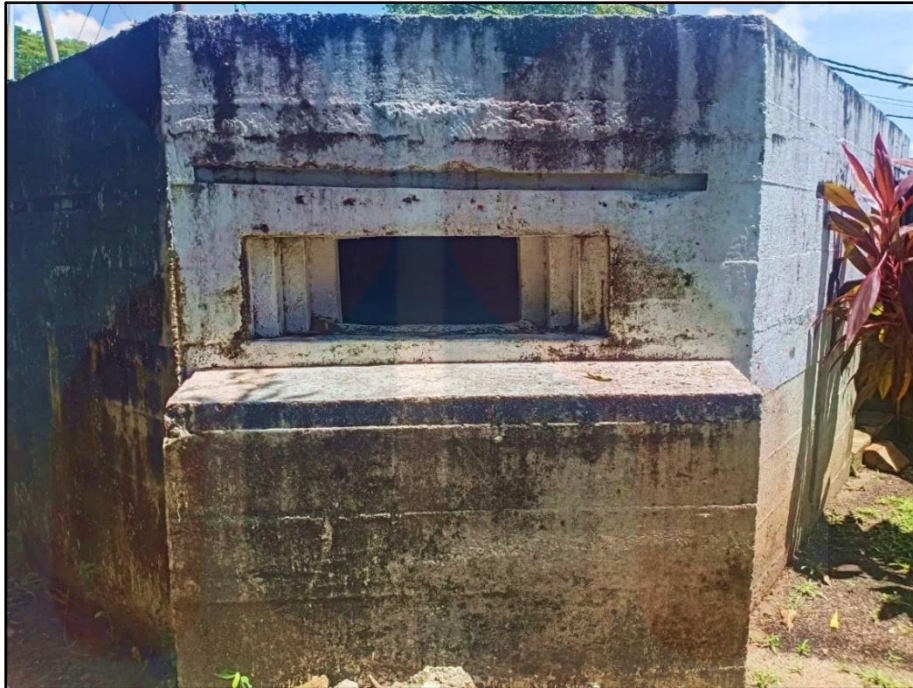
GAMBAR 4.33 : 'Buttress' Type A pada kubu kebal (pillbox) 'Type 22'
