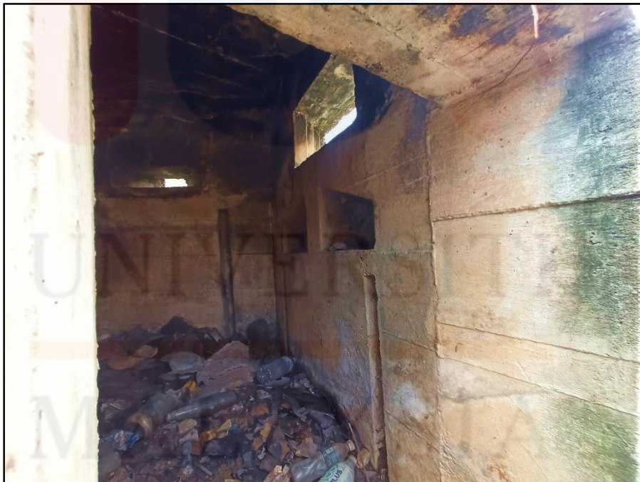
GAMBAR 4.56 : Elemen para kayu pada tipologi kubu kebal ( pillbox ) 'Pentagon' yang telah hilang.
