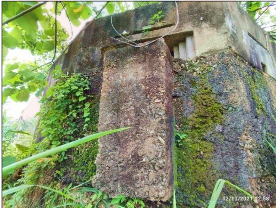
GAMBAR 4.35 : 'Buttress' Type C pada kubu kebal (pillbox) 'Type 22'
