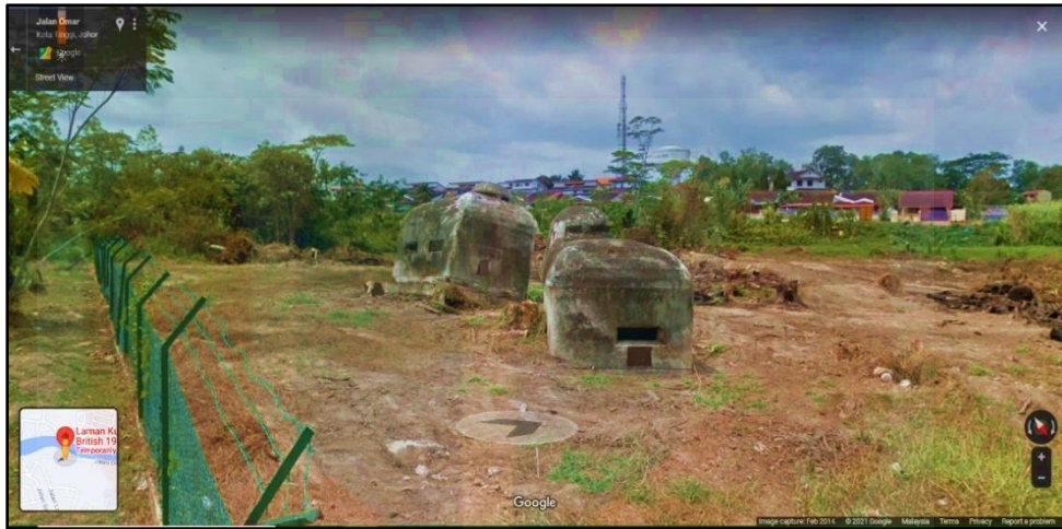
GAMBAR 2.28 : Tangkap layar keadaan kubu kebal di Jalan Omar, Taman Sri Lalang, Kota Tinggi, Johor sebelum dinaik taraf sebagai taman rekreasi.
