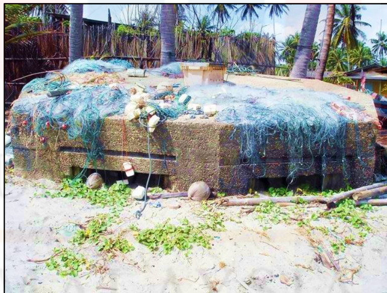
GAMBAR 2.23 : Kubu kebal 'pillbox' tipologi Type 22 yang terdapat di Kampung Pantai Baru, Bachok, Kelantan Darul Naim.
