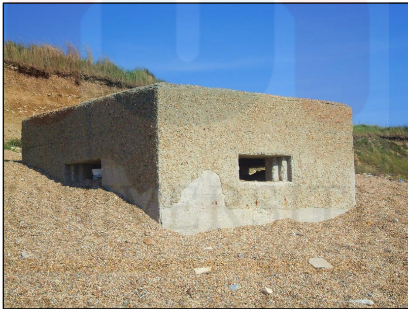
GAMBAR 2.13 : Kubu kebal ( pillbox ) tipologi Type 26 (FW3/26) yang terdapat di Chesil Beach, West Bexington, Dorset, England.
