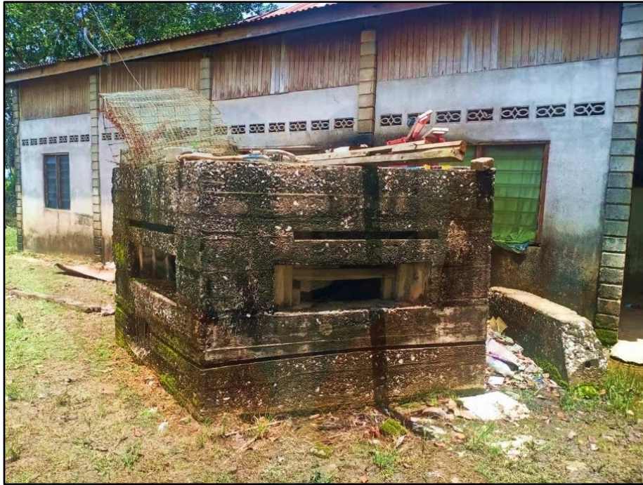
GAMBAR 4.57 : Kubu kebal ( pillbox ) 'Pentagon' tiada elemen 'buttress'.
