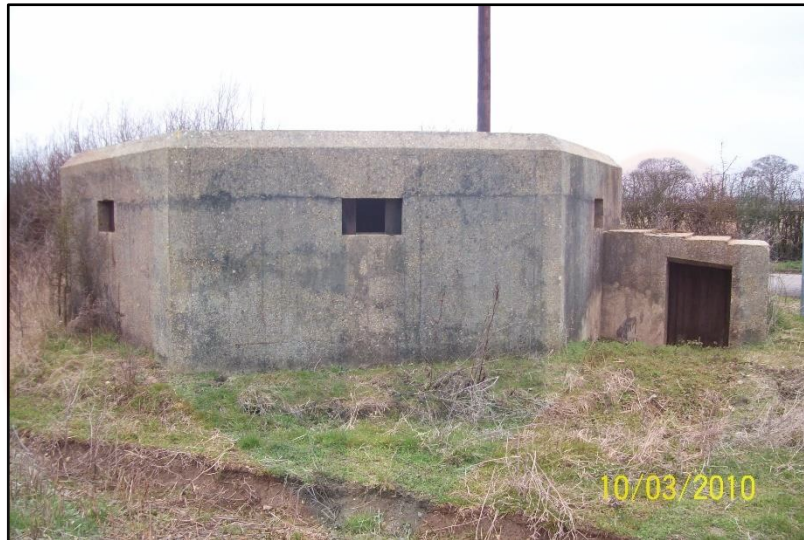
GAMBAR 2.15 : Kubu kebal ( pillbox ) tipologi 'Type 27' (FW3/27) yang terdapat di Colchester Road, Stones Green, United Kingdom.
