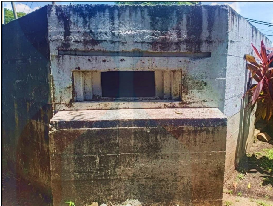
GAMBAR 4.31 : Dinding ' Type B ' pada kubu kebal ( pillbox ) ' Type 22 '
