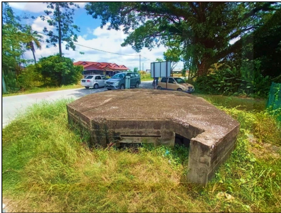
GAMBAR 4.39 : Pintu masuk 'Type B' pada kubu kebal ( pillbox ) 'Type 22'
