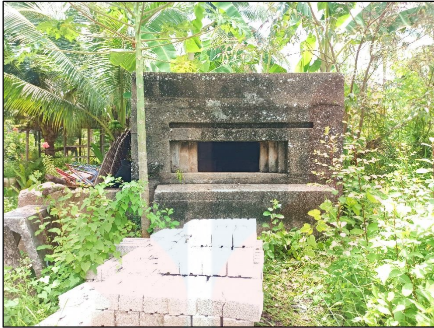
GAMBAR 4.7 : Pillbox pertama di mukim Bukit Tinggi, Kedah Darul Aman.
