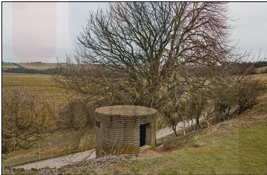
GAMBAR 2.11 : Kubu kebal ( pillbox ) tipologi Type 24 (FW3/24) yang terdapat di South Beach, Studland Bay, United Kingdom
