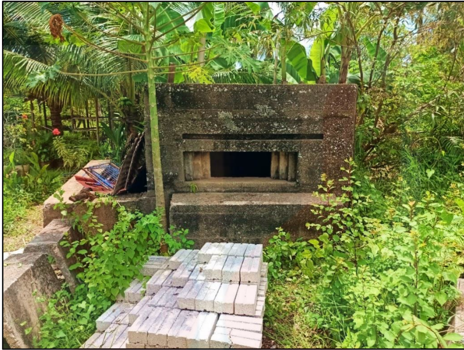
GAMBAR 4.55 : Kubu kebal ( pillbox ) 'Pentagon' dengan elemen 'buttress'
