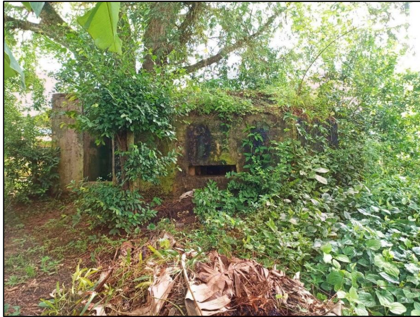
GAMBAR 4.6 : Pillbox keempat di Mukim Gelong, Kedah.
