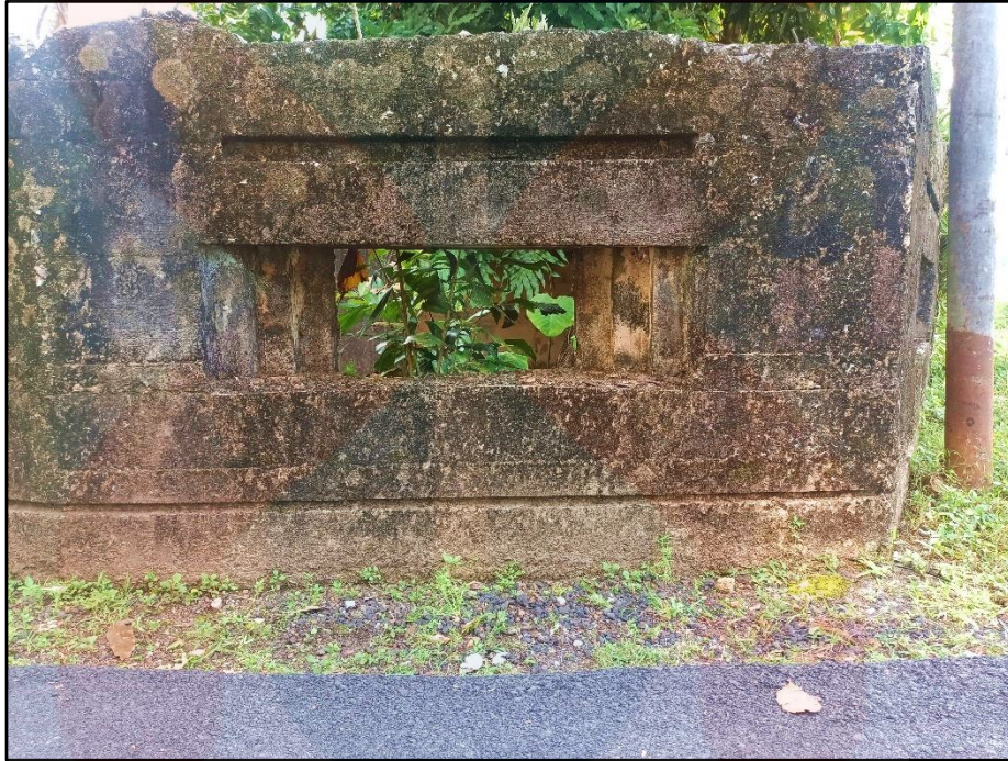
GAMBAR 4.30 : Dinding 'Type A' pada kubu kebal (pillbox) 'Type 22'
