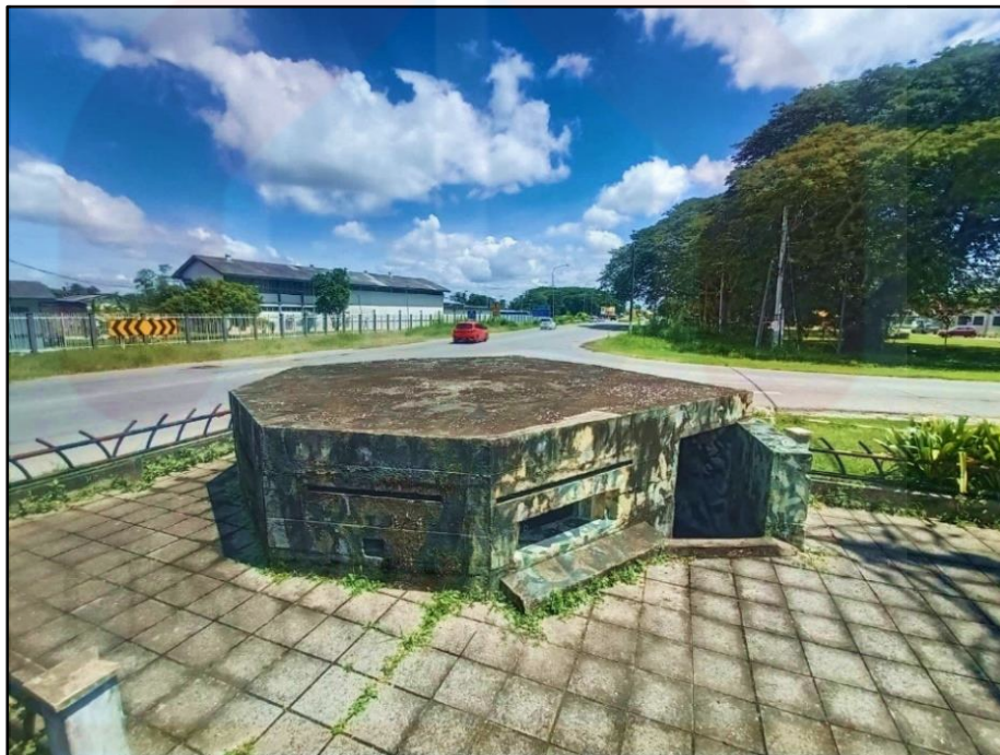
GAMBAR 4.38 : Pintu masuk 'Type A' pada kubu kebal ( pillbox ) 'Type 22'
