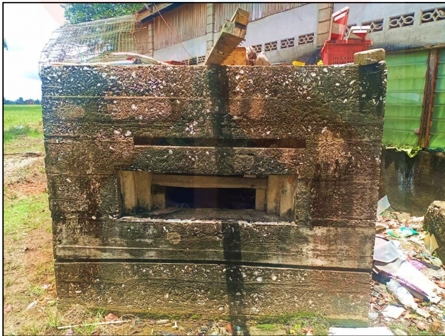
GAMBAR 4.44 : Dinding Kubu kebal ( pillbox ) tipologi ' Pentagon Type A '.
