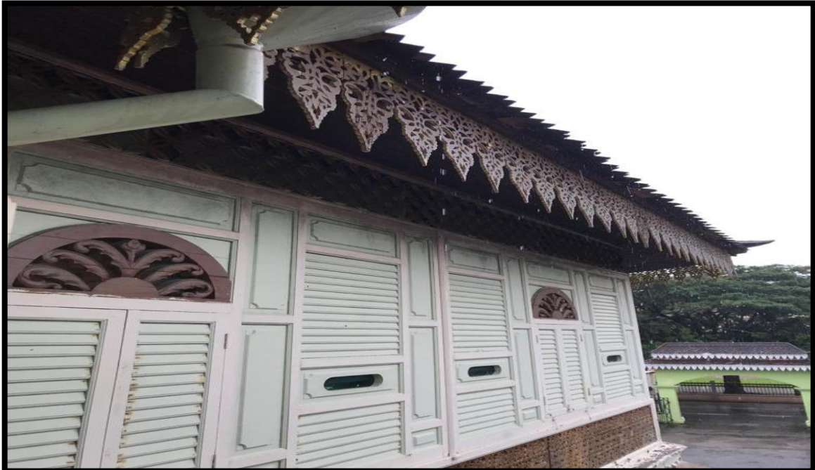
Gambar 4.4 : Dinding Susun Sireh pada bahagian luar dan Seni Ukir Pucuk Rebung pada Andang-andang Muzium Islam
