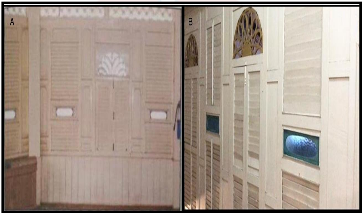
Gambar 4.16 : Dinding anjung sebelum dikonservasi (A) dan Dinding anjung selepas dikonservasi (B) (Sumber : Norsyazwani Din, 2021)
