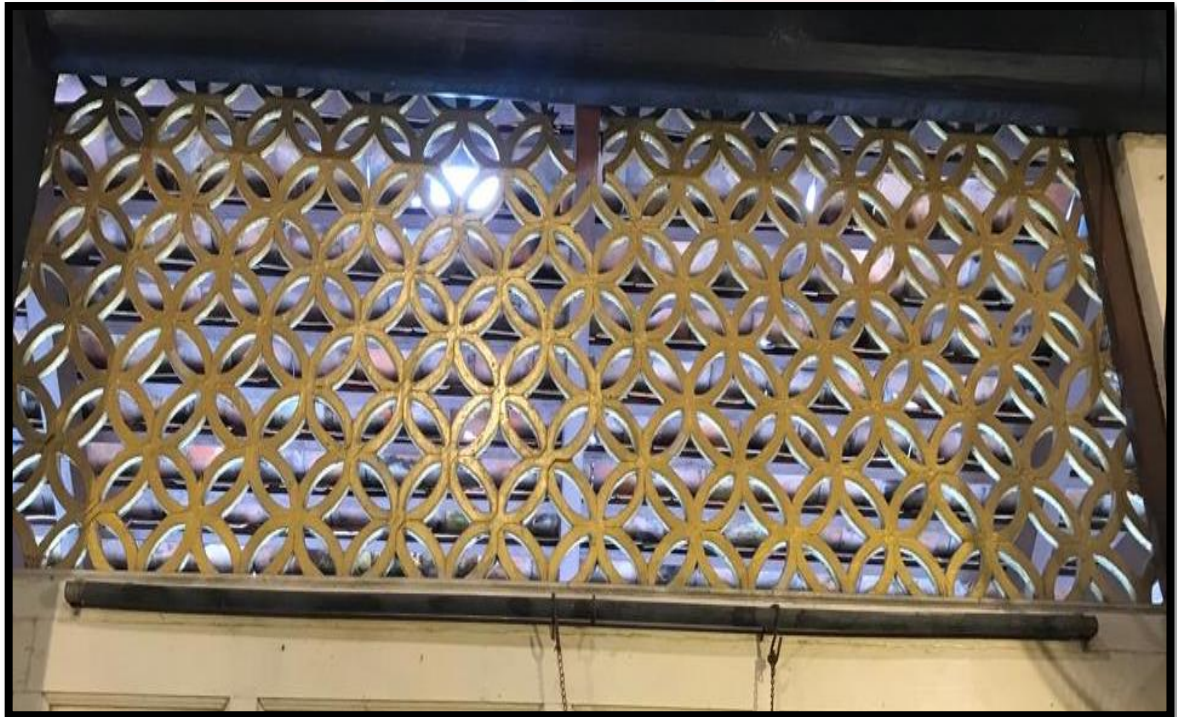
Gambar 4.23 : Ukiran Tebuk Tembus Tidak Silat pada bahagian atas dinding (Sumber : Norsyazwani Din, 2021)
