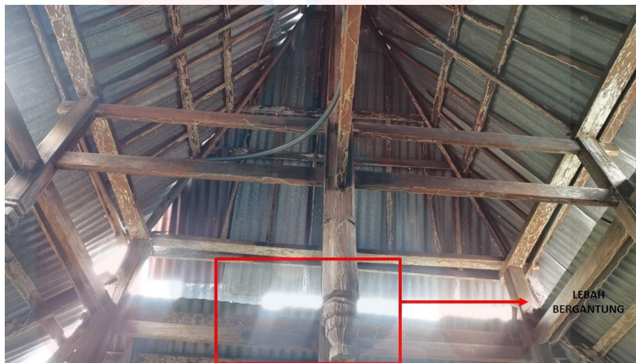
Rajah 4.4.8 : Struktur bumbung dalam dan kedudukan lebah bergantung
