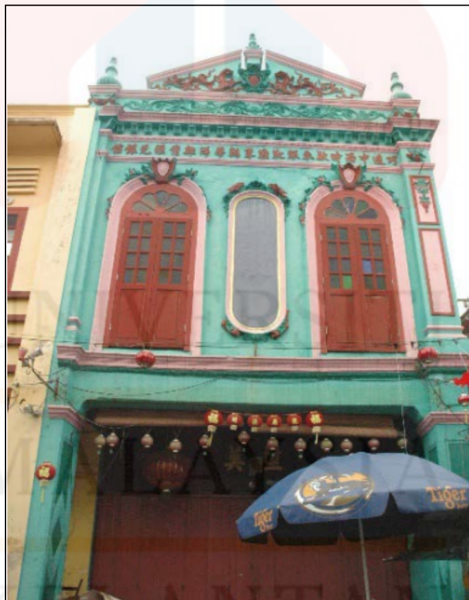
Gambar 9: Reka bentuk fasad rumah kedai Gaya Eklektik Cina Selatan di Melaka
