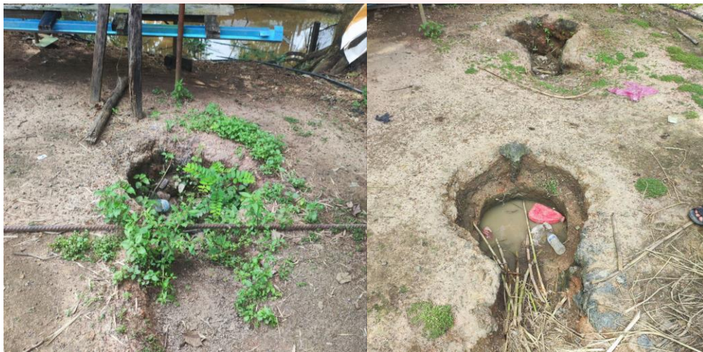
Rajah 4.2: Kedehqok Lubang Tanah Tidak Kekal
