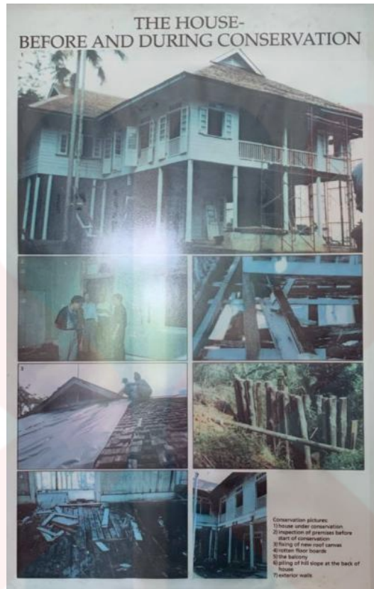
Foto 4.8: Dokumen kerja konservasi bangunan Rumah Agnes Keith. Sumber : Kajian Lapangan (2023)
