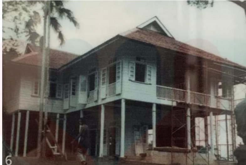
Foto 4.7 : Kerja-kerja Konservasi bangunan Sumber : Kajian Lapangan (2023)
