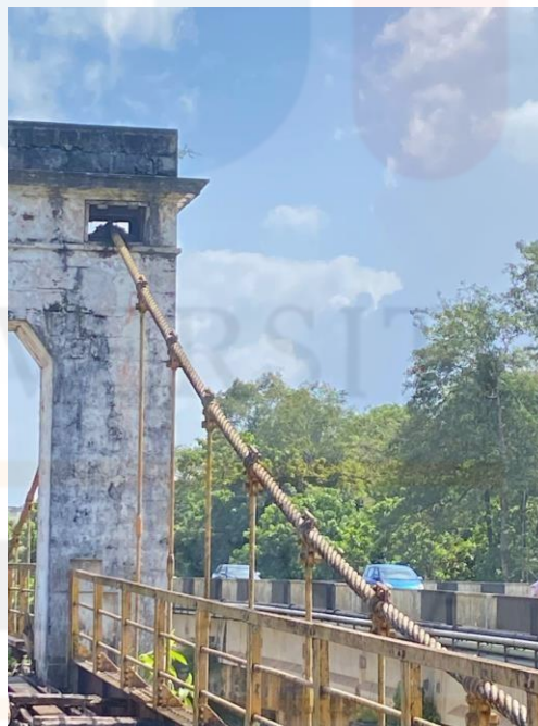
Rajah 4.14: Kabel utama Jambatan Gantung, Sultan Ismail, Kuala Krai, Kelantan
