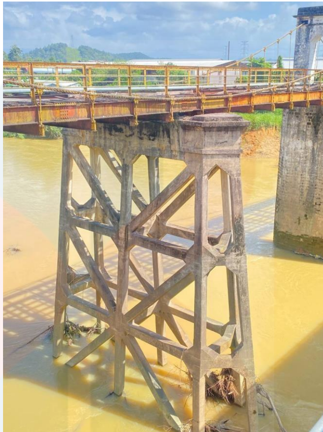
Rajah 4.12: Struktur penahan tengah Jambatan Gantung, Sultan Ismail, Kuala Krai, Kelantan
