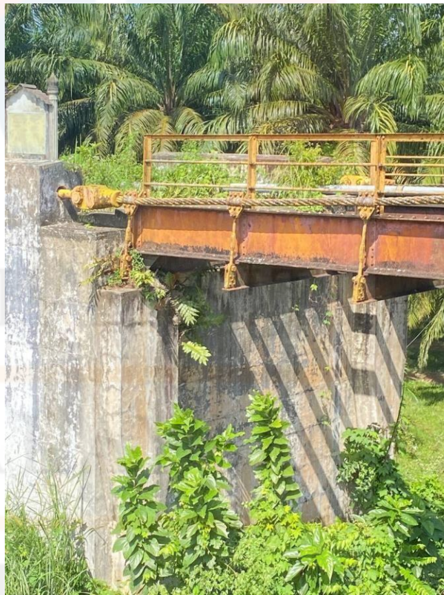
Rajah 4.10: Tembok penahan arah utara Jambatan Gantung, Sultan Ismail, Kuala Krai, Kelantan
