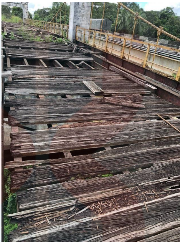
Rajah 4.7: Kemasan kayu pelantar laluan kenderaan dan pejalan kaki Jambatan Gantung, Sultan Ismail, Kuala Krai, Kelantan
