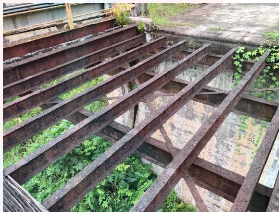
Rajah 4.6: Struktur kerangka platform Jambatan Gantung, Sultan Ismail, Kuala Krai, Kelantan
