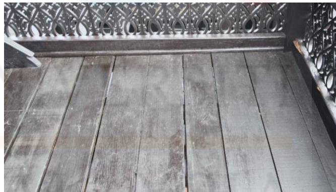
Rajah 4.9 Lantai mempunyai lubang angin
