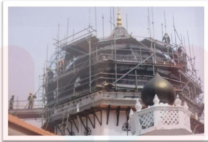
Rajah 5.3: Proses pembaikpulihan kubah Masjid Kapitan Keling pada 2010
