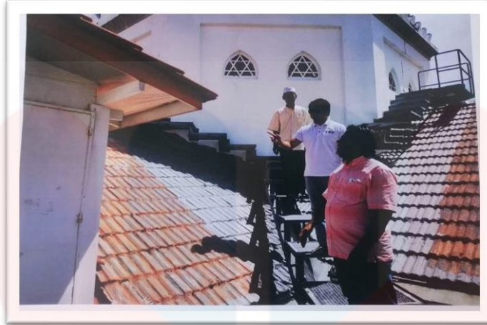
Rajah 4.8: Proses pemantauan kerosakan bangunan Masjid Kapitan Keling
