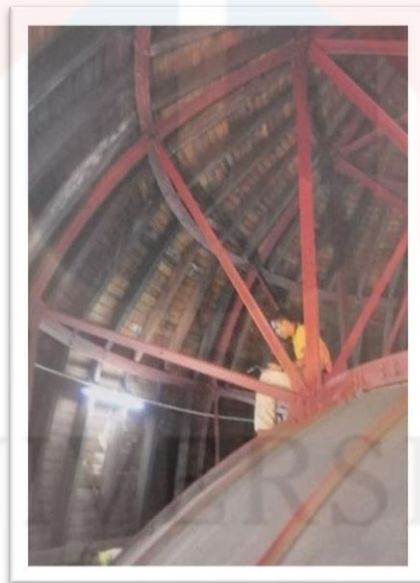
Rajah 5.4: Proses pembaikpulihan kubah Masjid Kapitan Keling pada 2010
