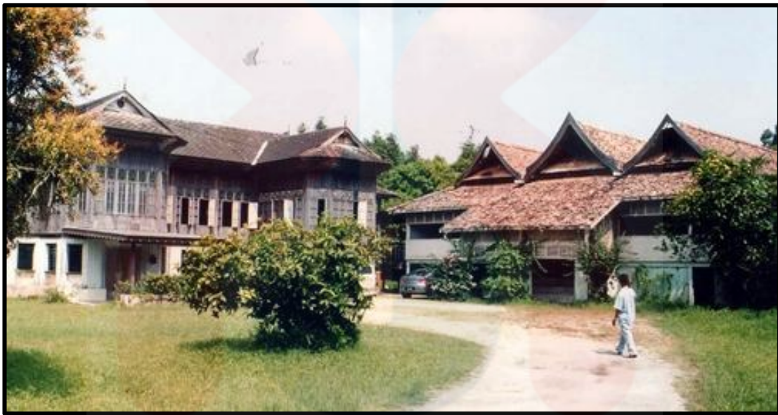
Gambar 2.4 : Rumah Warisan Haji Su sebelum Konservasi
